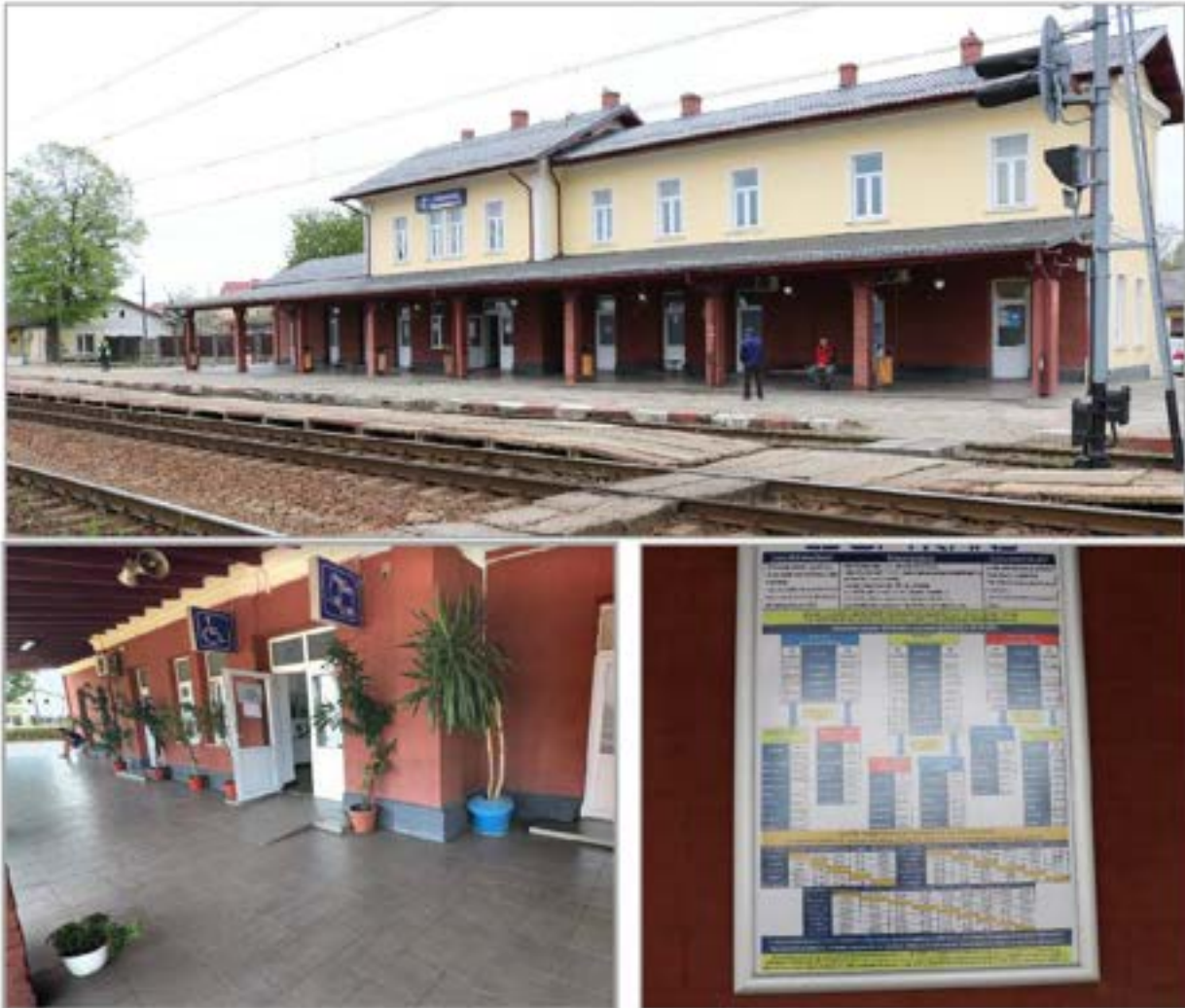
Figura 2.63. Stația de cale ferată Caracal - amenajări existente.
