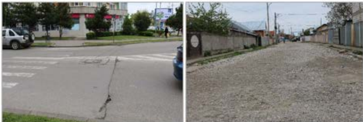
Figura 2.24. Străzi a căror suprafață de rulare se află în stare tehnică proastă/ neasfaltate (Exemplificare).
