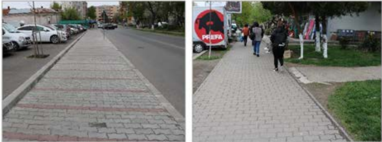
Figura 2.46. Trotuare în stare bună (Exemplificare).
