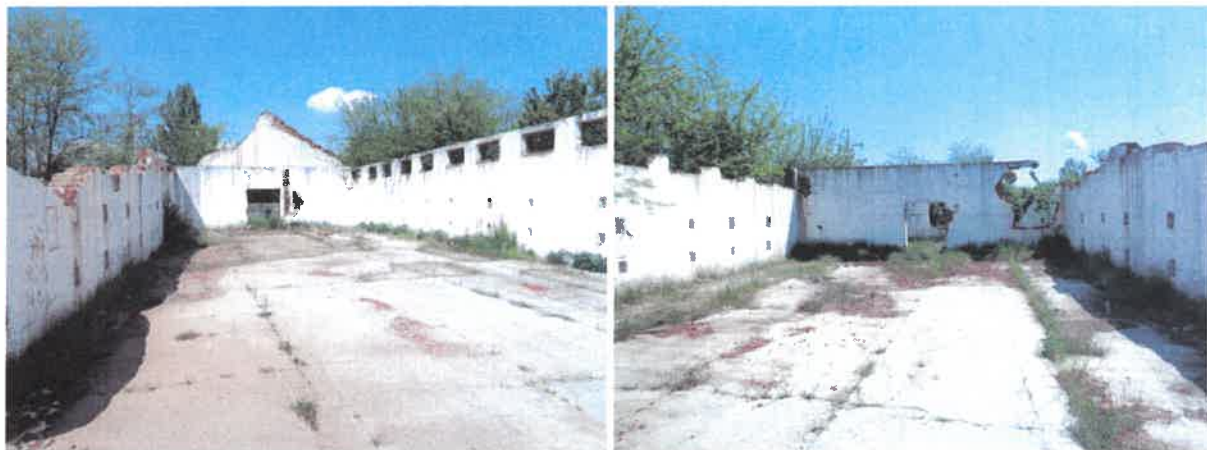
CONSTRUCȚIE ȘI PLATFORMA BETONATA LATURA ESTICĂ
