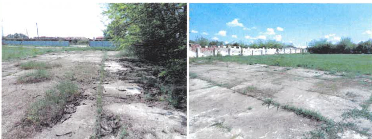
PLATFORMĂ BETONATĂ LATURA NORDICĂ
