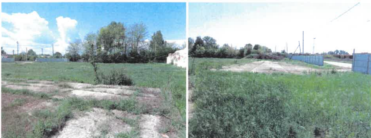
PLATFORMĂ BETONATĂ LATURA SUDICĂ ȘI VESTICĂ
